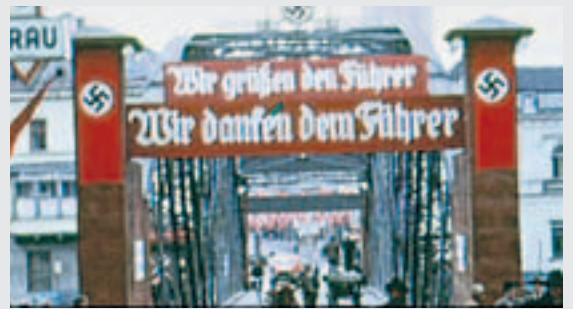
Villach 1938: reich beflaggte Draubrücke
